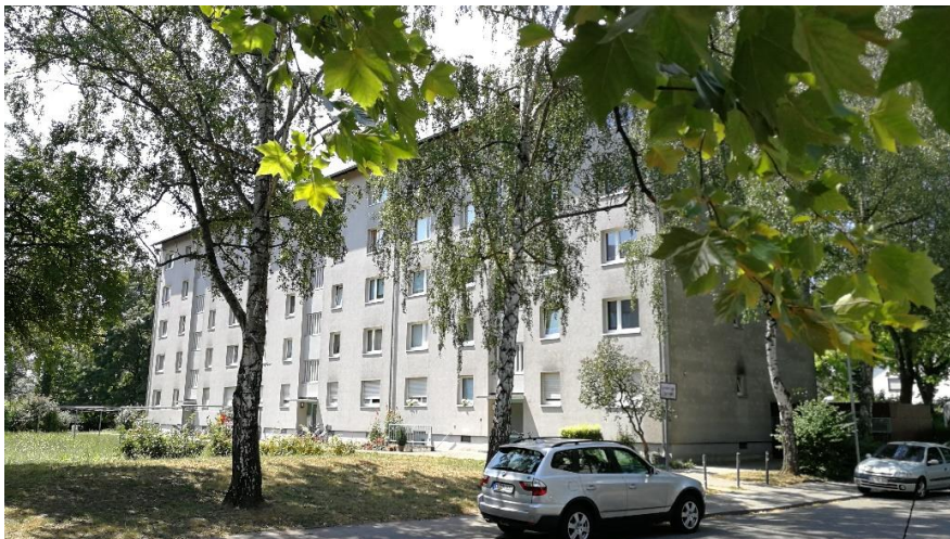
Bild 1: Typisches MFH-Bestandsgebäude in Karlsruhe mit insgesamt 30 Wohneinheiten aufgeteilt auf drei Treppenhäuser mit 5 Vollgeschossen (jeweils Zweispänner).
